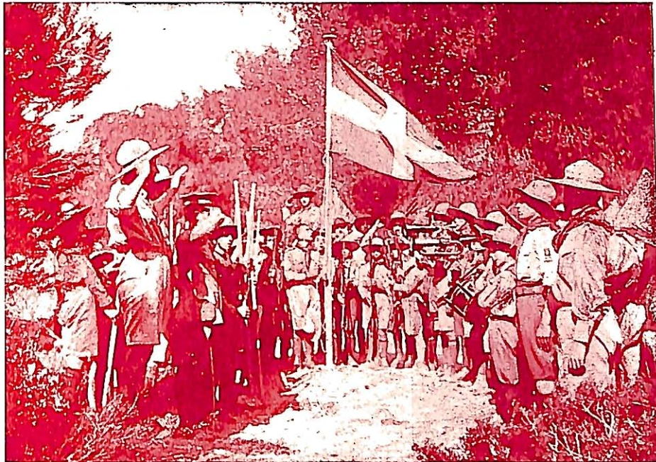
Ἐπαρσις Σημιαλᾶς Σώματος Πειραιῶς, εἰς θέσιν Ἐλυφάδα,
